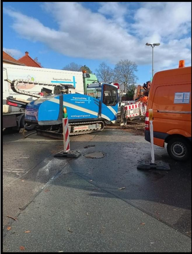
Auf der Kreuzung Lerchenweg und Mülsener Straße habt ihr sicher schon die Bautätigkeiten der letzten Tage mitbekommen. Dort baut die Mitnetz AG eine dicke Stromleitung in Richtung Umspannwerk Eckersbach für den Anschluss weiterer geplanter Windkraftträder und Solarfelder im Raum Zwickau und Mülsen.
